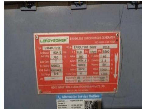
**Gambar 1. Spesifikasi Generator di PLTSa Bantargebang**
