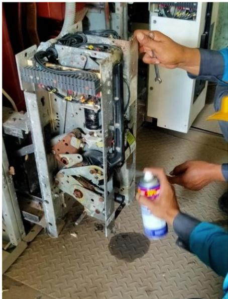
**Gambar 6. Penyemporan Penetrangan Oil**
