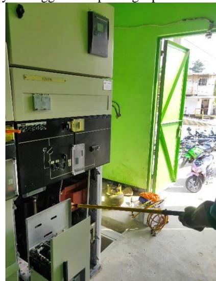
Gambar 3. Mengecek Tegangan pada Kubikel 20 kV
