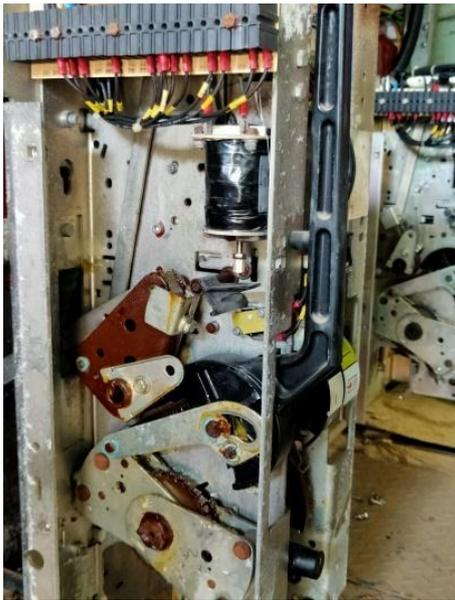
**Gambar 5. Korosi yang ada di dalam PMT Pelanggan**
