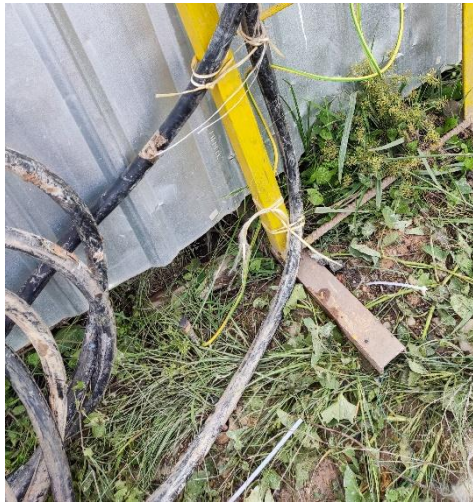
Gambar 14. Pemasangan Kabel Ground ke dalam Tanah
