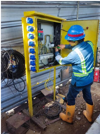
Gambar 8. Proses Pemasangan Komponen kedalam Box Panel
