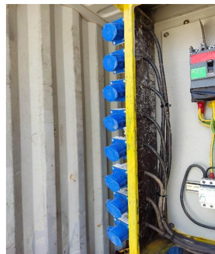
Gambar 13. Pemasangan Kabel In pada Stop Kontak 3 Pole
