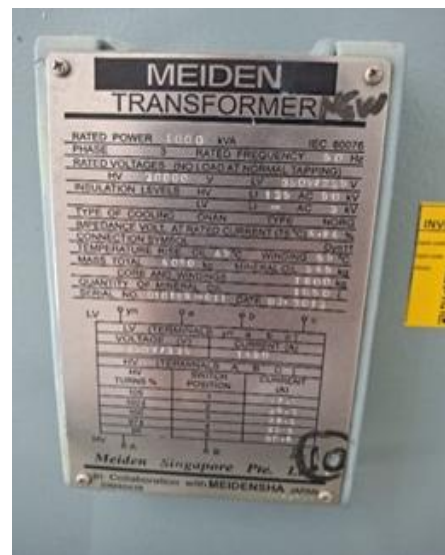
Gambar 2. Spesifikasi Transformator
