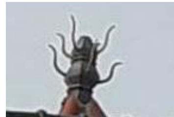
Gambar 3. Puncak Atap / Memolo Pada Bangunan Masjid Utama Masjid Agung Lamongan
