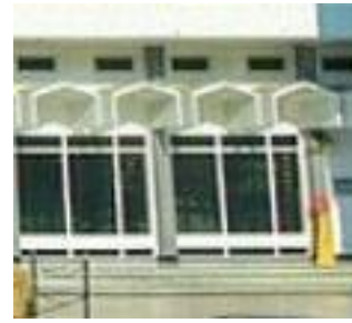
Gambar 8. Bentuk Pintu, Jendela Dan Tritisan Pada Bangunan Sisi Timur 1980-An
